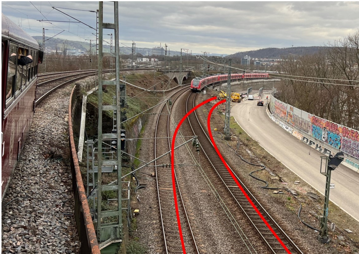
Bild 3: Die Gäubahn verläuft links im Bild, in der Mitte die bestehende S-Bahntrasse. Die roten Linien zeigen, wie die S-Bahngleise zur Mittnachtstraße verschwenkt werden. Dies ist ohne Eingriff in den Gäubahn-Damm möglich. Foto: R. König
